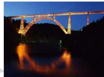
Viaduc de Garabit
